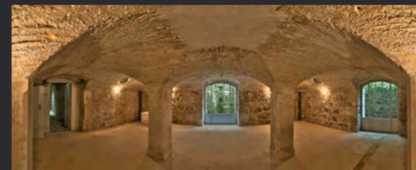
Les caves des serres de la Fondation Hardt à Vandoeuvres
