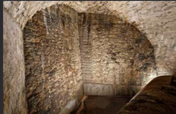
Le deuxième sous-sol de l'immeuble rue de l'Athénée 4
