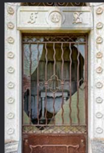
Des caveaux abandonnés à l'avenue du cimetière de Saint-Georges
