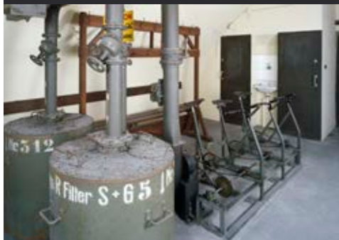
Le poste de commandement de la Défense aérienne passive (DAP) à la Treille
