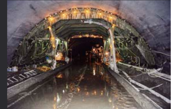
Le tunnel de Vernier en chantier
