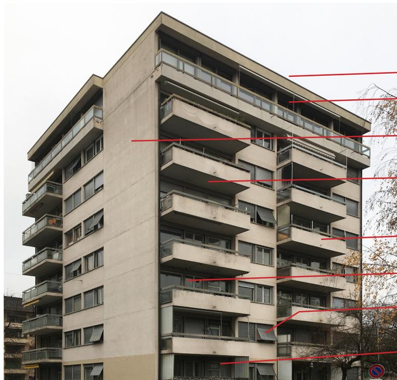
Le chauffage est assuré par des radiateurs et un chauffage central. La ventilation est en simple flux, avec en général une extraction mécanique dans les salles d'eau et les cuisines. La construction est assez économique, des problèmes d'isolation phonique peuvent être relevés (dalles sans chapes, parois non isolées).
